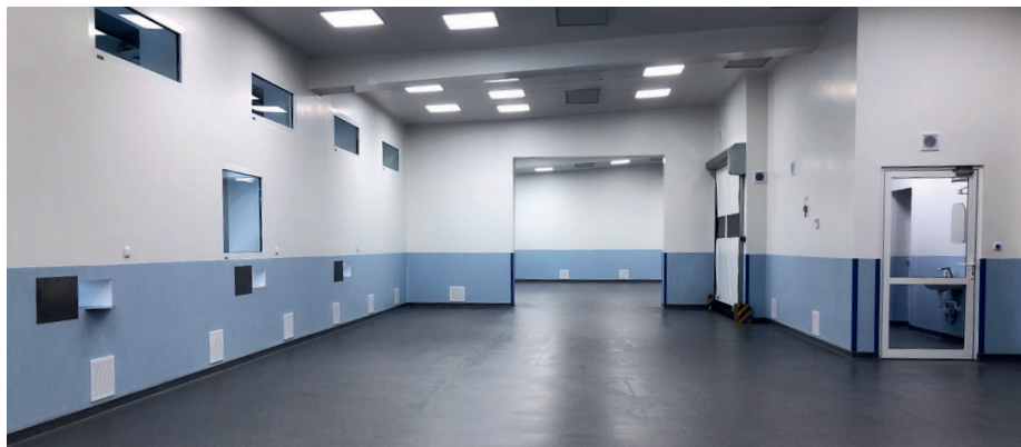
Det nya renrummet innan formsprutorna flyttade in.
