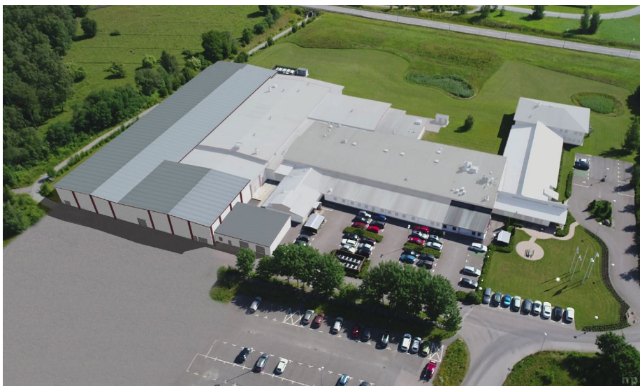
Fabriken i Hörby byggs ut med 3.700 kvm produktionsyta, delen med gråare tak ovan.
