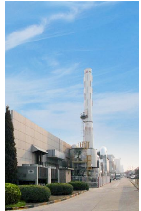
En ny reningsanläggning vid Nolatos lackeringsanläggning i Beijing installerades under 2014.
